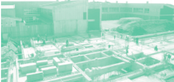
第2期工事中の富津中学校
