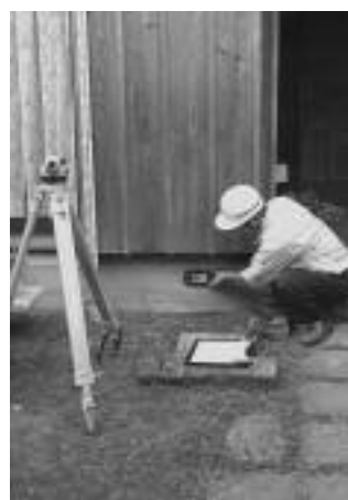
耐震診断の様子 鉄筋の使用状況などを調査しています。(写真)
