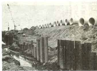
区画整備内の下水道工事
